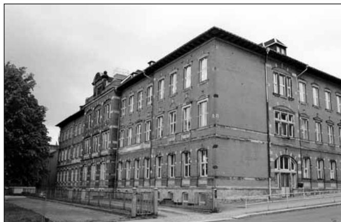
Die Grundschule Altendorf. Foto: Grundschule
