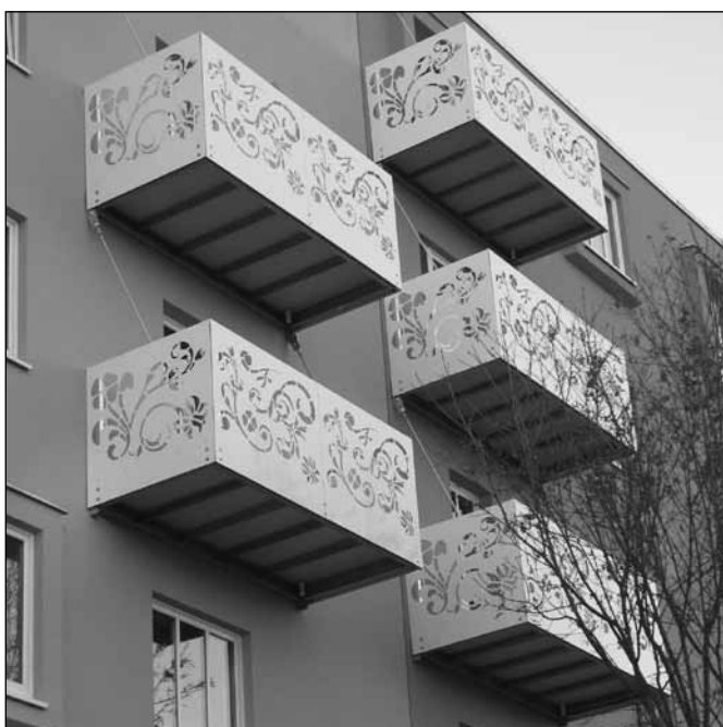
Schon gesehen? Am Gebäude Richter-/Konradstraße wurden in den letzten Wochen Balkone mit phantasievollen Verzierungen montiert.
