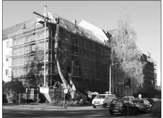
Sanierung der Erich-Mühsam-Straße 13. Foto: GGG
