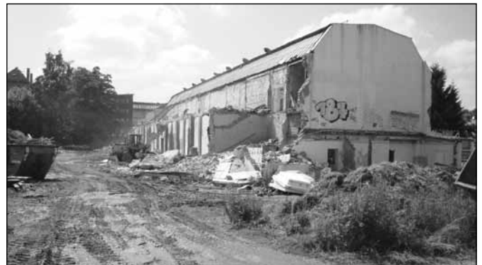
Die ehemalige Elan-Halle wurde 2009 abgerissen.
