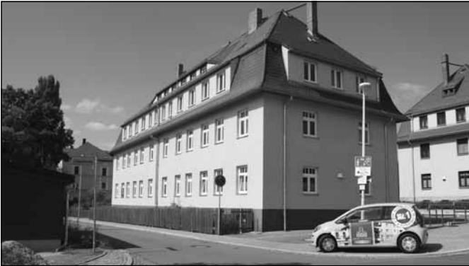
Schloßchemnitz: Altendorfer Straße 36-38: Innenausbau im bewohnten Zustand. Leistungsinhalte: Schaffung einer familienfreundlichen Grundrissauswahl aus 3- bis 5-Raum-Wohnungen, Erneuerung der Haustechnik, Anbau von Balkonen.
