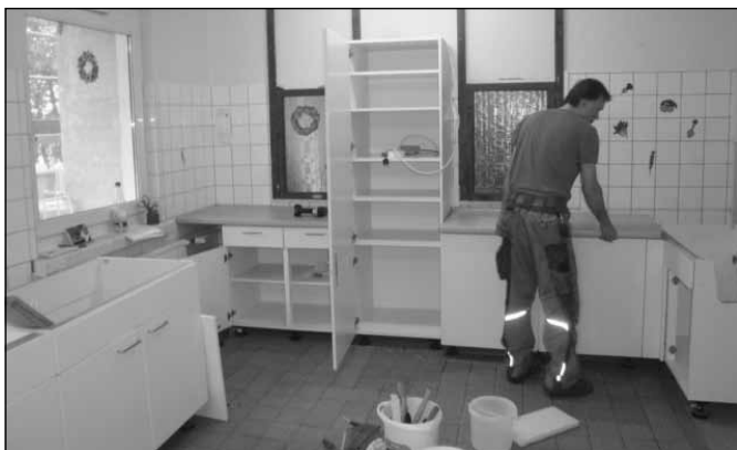
Baumaßnahmen in der Begegnungsstätte. Fotos: Beier
