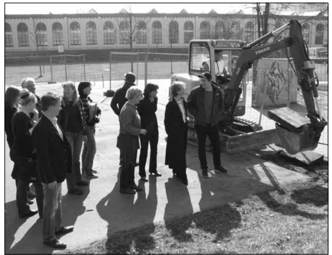
Baubürgermeisterin Petra Wesslerer (2.v.r.) ließ es sich nicht nehmen, beim symbolischen ersten Spatenstich zur Erneuerung der Skateranlage dabei zu sein.
